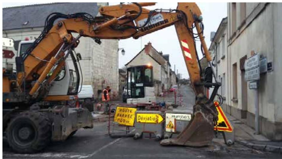
Changeement des canalisations d'eau route de Crissay, par le SIAEP (syndicat intercommunal d'alimentation en eau potable)
