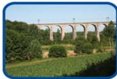
12 Viaduc de Besnault
